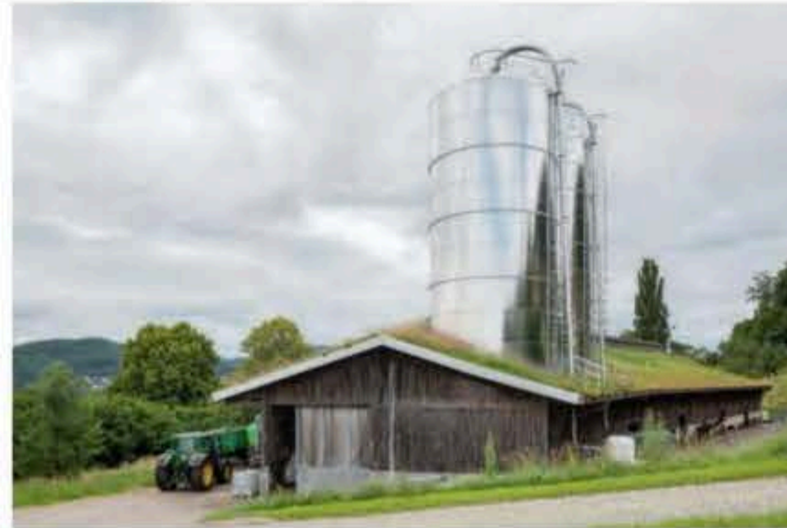
Schönenberg: Zwei Silos ragen aus dem begrünten Dach. Foto: Markus Frietsch
